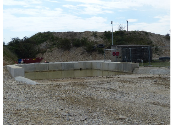
Figure 6: Aire de lavage des bennes de camions
