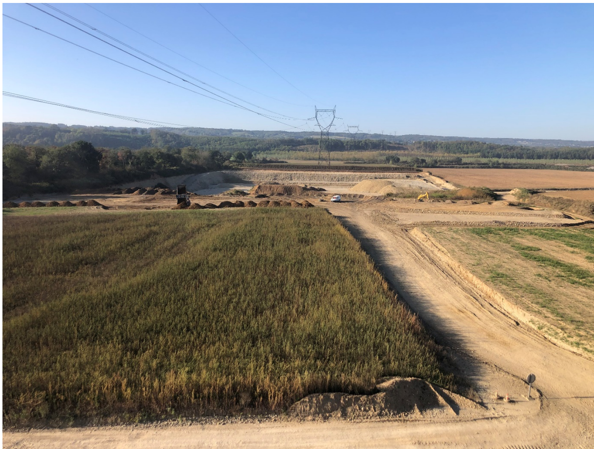
Figure 17 : Etat d'avancement de l'extraction et du remblaiement sur les phases 3 et 4 (cliché PHV octobre 2023)
