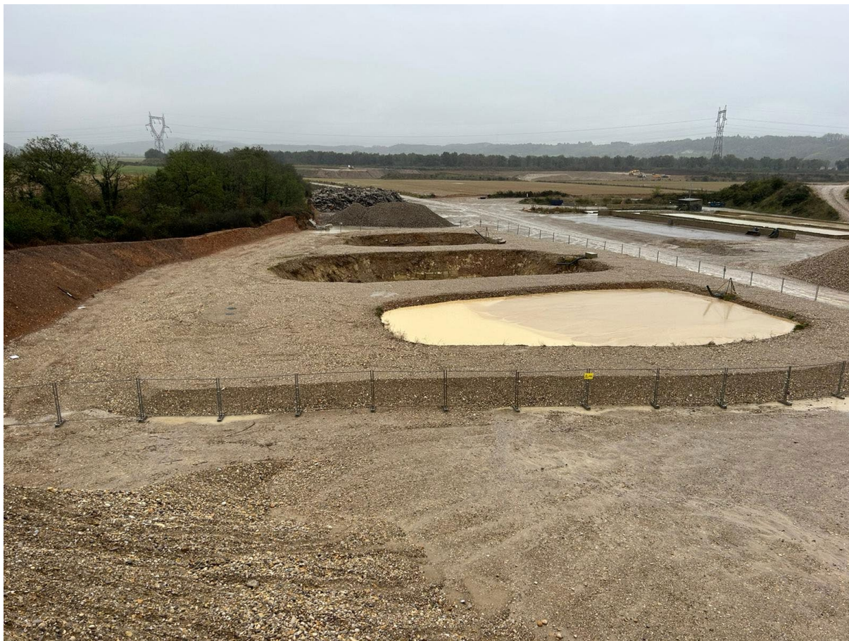
Figure 14 : Configuration des nouveaux bassins de séchage de boues de l'ITM "Roche" (cliclé PHV 10/2023)
